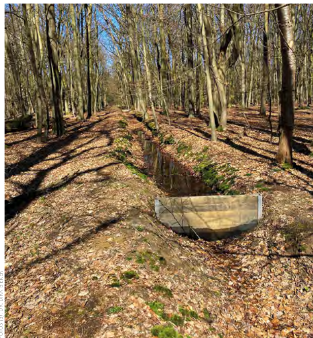
Regulierbarer Grabenstau entlang einer zentralen Rückegasse.
